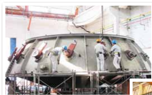
石虎塘机组4#号水机机构装配中
