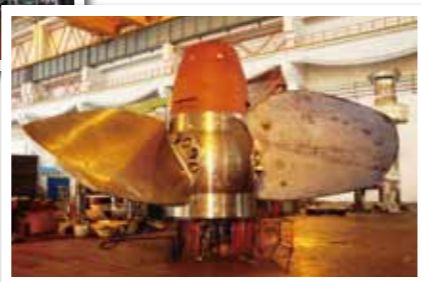
石虎塘机组转轮安装中
