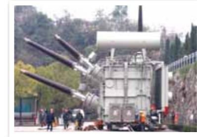
换流变压器在葛洲坝现场安装
