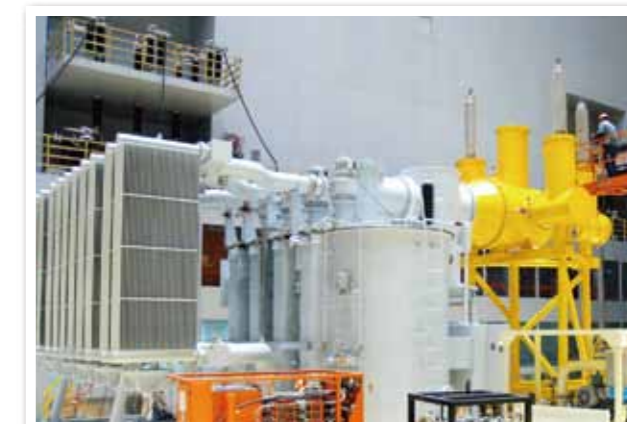
SF6(六氟化硫)气体变压器正在进行气密试验
